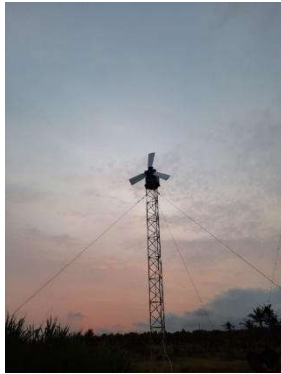
Gambar 15. Implementasi turbin angin AFPMG pada tiang 5 meter
