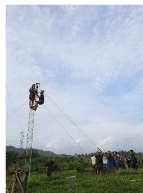
Gambar 14. Proses pemasangan turbin angin pada tiang
